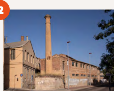
12 Cheminée del Tint del Pallerols C. del Rec, 2-6
